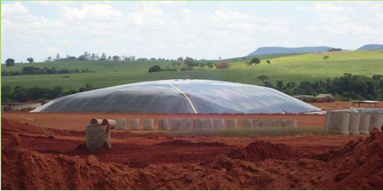
**Biodigestores, p.e. membrana de Polietileno de Alta Densidad**
